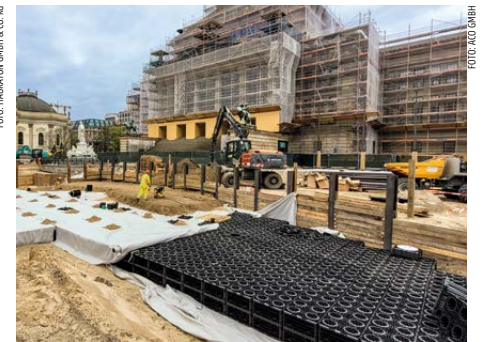
Eine Regenwassernutzungsanlage im Garten kombiniert die Rückhaltung von Wasser zur Entlastung der Kanalisation mit der anschließenden privaten Nutzung, beispielsweise für die Pflanzenbewässerung (L.). Einbau eines Regenrinnensystems im Zuge einer Straßensanierung (M.). Einbau von Blockrigolen als Versickerungs- und Rückhalteanlage von Oberflächenwasser im städtischen Raum (r.).
