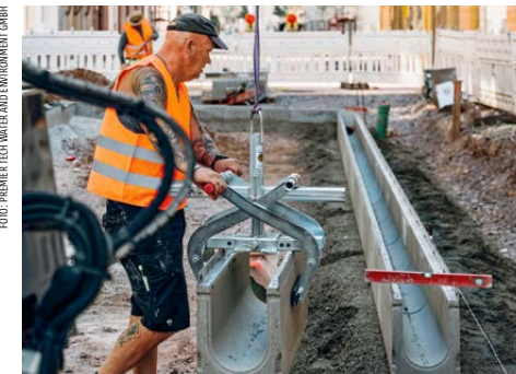
Eine Regenwassernutzungsanlage im Garten kombiniert die Rückhaltung von Wasser zur Entlastung der Kanalisation mit der anschließenden privaten Nutzung, beispielsweise für die Pflanzenbewässerung (L.). Einbau eines Regenrinnensystems im Zuge einer Straßensanierung (M.). Einbau von Blockrigolen als Versickerungs- und Rückhalteanlage von Oberflächenwasser im städtischen Raum (r.).
